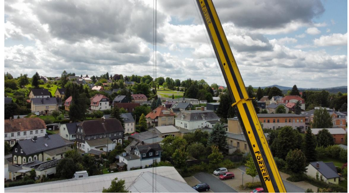
Heben und Einbringen der Bauteile
