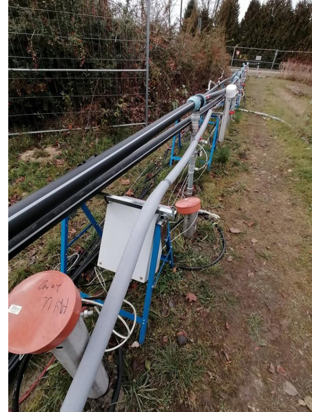
Abb. 9: Leitungen und Anschlüsse im Sanierungsfeld, Zustand 20.11.2025
