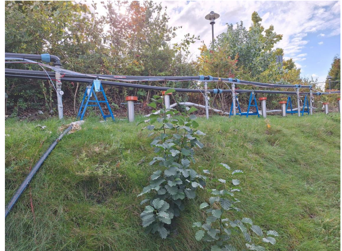
Leitungsführung im Sanierungsfeld
