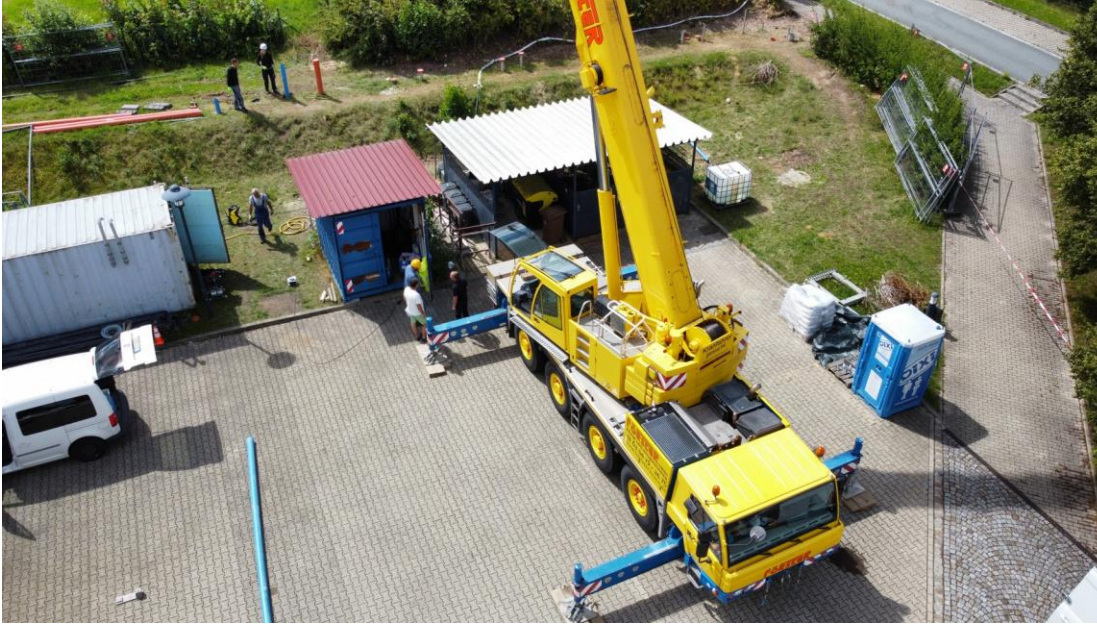
Kranstellplatz und Arbeitsbereich
