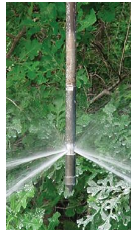
Einbringung des Provect-IR von Provectus
