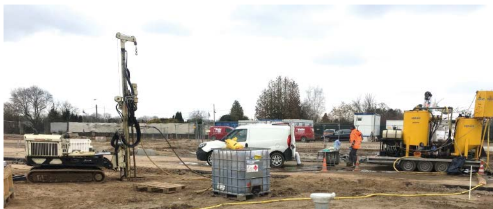
Abbildung 3: EHC-Eingabe (Bohrgerät links, Mischanlage rechts)
