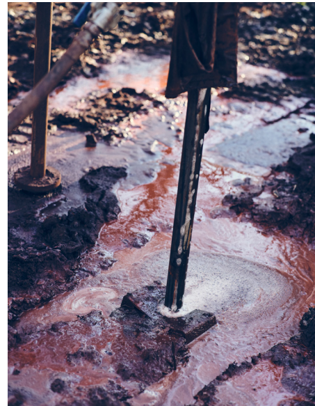
Spezielle Bohrmaschinen treiben Metallrohre in die Erde, durch die Reagenzien ins Erdreich gepumpt werden
