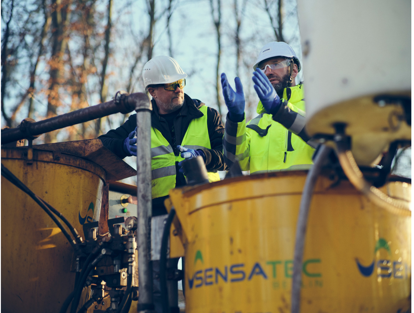
In Mischmaschinen wird das Reagenz mit Wasser zu einer dickflüssigen Masse verrührt
