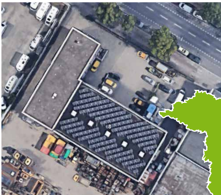
PV-Anlagen auf dem Dach der Niederlassung in Berlin
