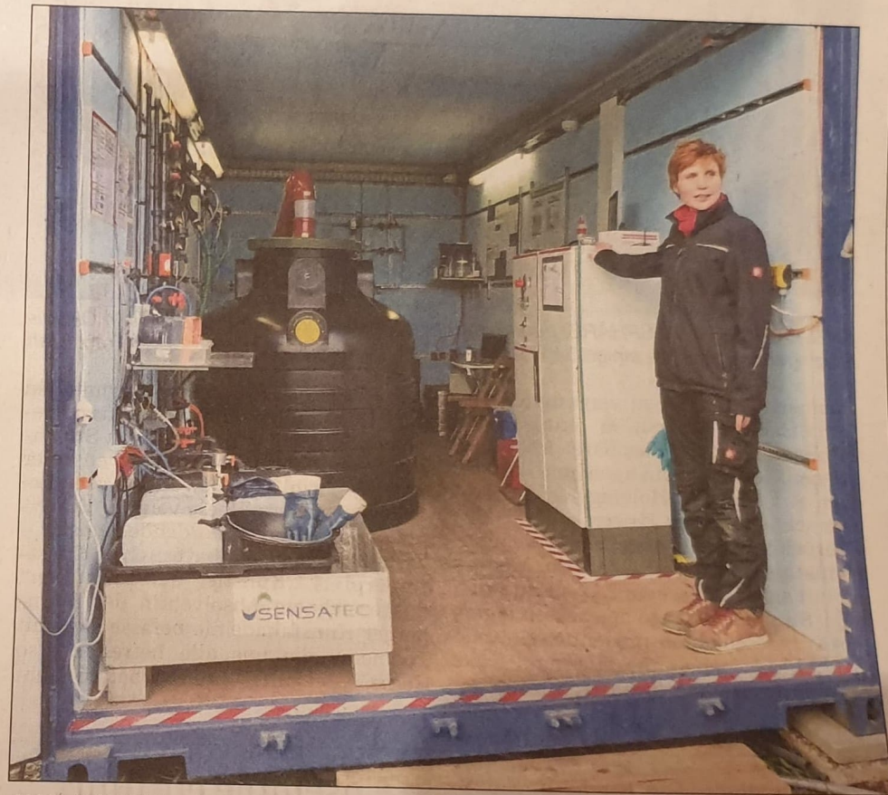
ANJA WILKEN von der Firma Sensatec erklärt die Steuerungs- und Anlagentechnik. In dem schwarzen Behälter wird der „PFC-Schaum“ vom Grundwasser getrennt. Foto: Klatt
