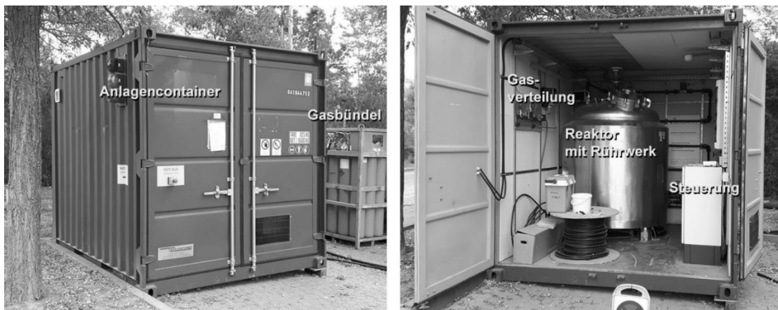
Abbildung 4: Anlagencontainer mit Sauerstoffversorgung auf dem Pilotstandort
