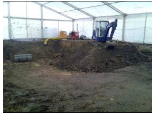
Abb. 2: Voraushub mit Einhausung
