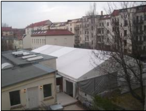
Abb. 2: Voraushub mit Einhausung
