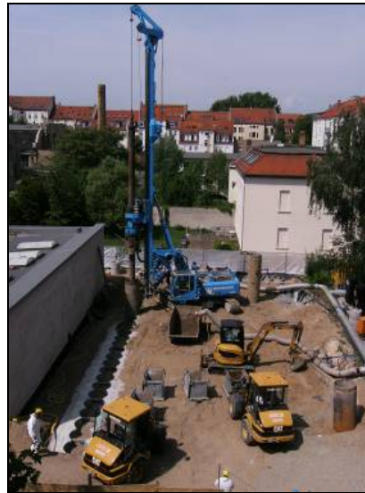
Abb. 3: Bodenaustausch im Großlochbohrverfahren
