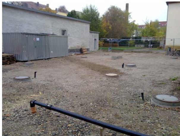
Abb. 6: Ansicht des Geländes während der Sanierungsphase 2, Methan-Biostimulation
